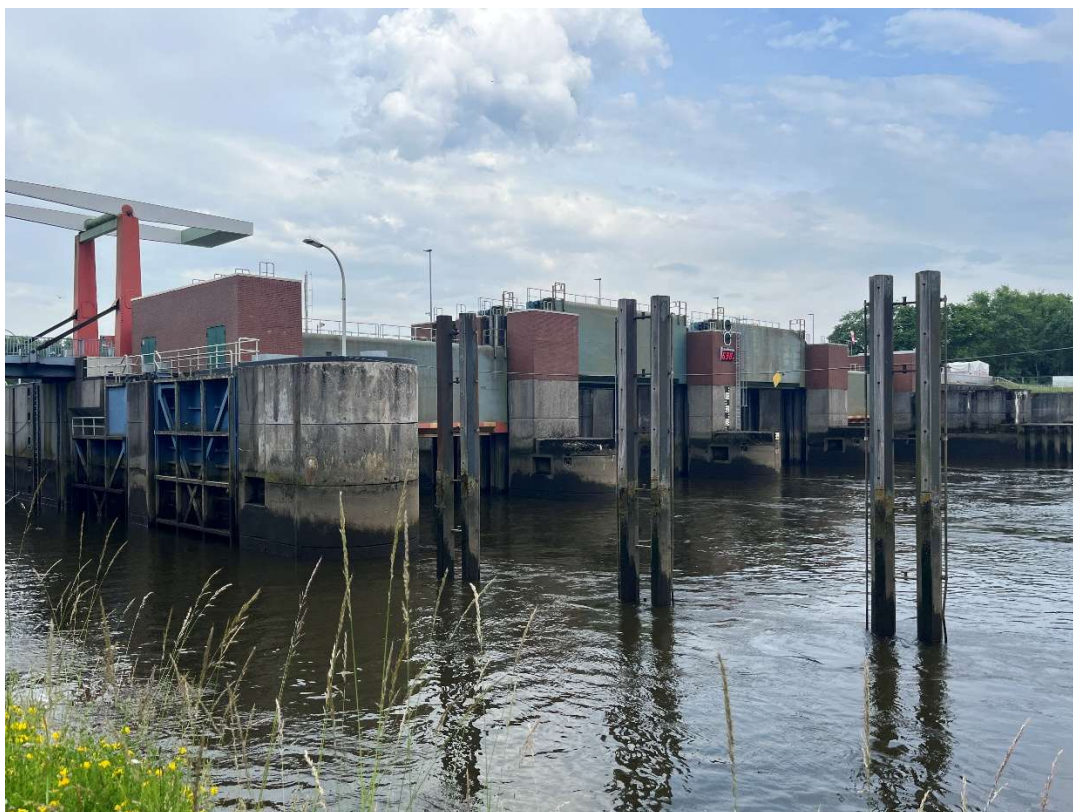
Foto 17: Blick auf das Sperrwerk von unterstrom
