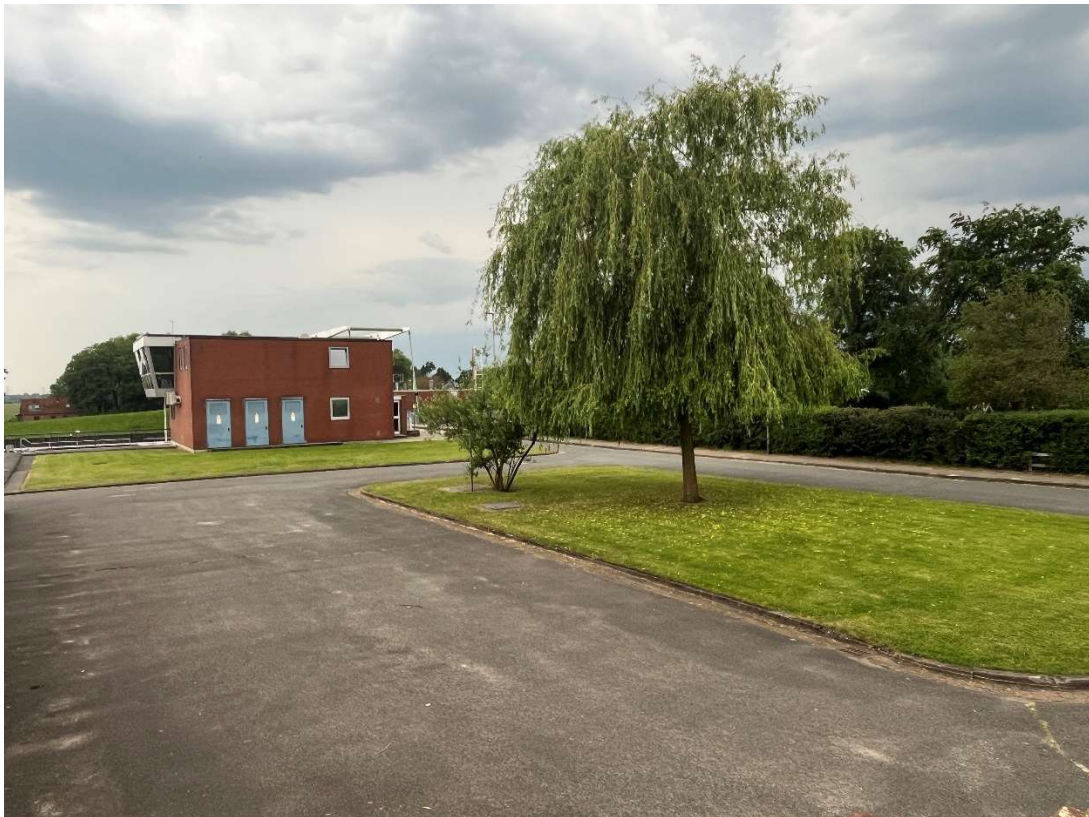
Foto 13: Betriebsfläche vor dem Sperrwerk
