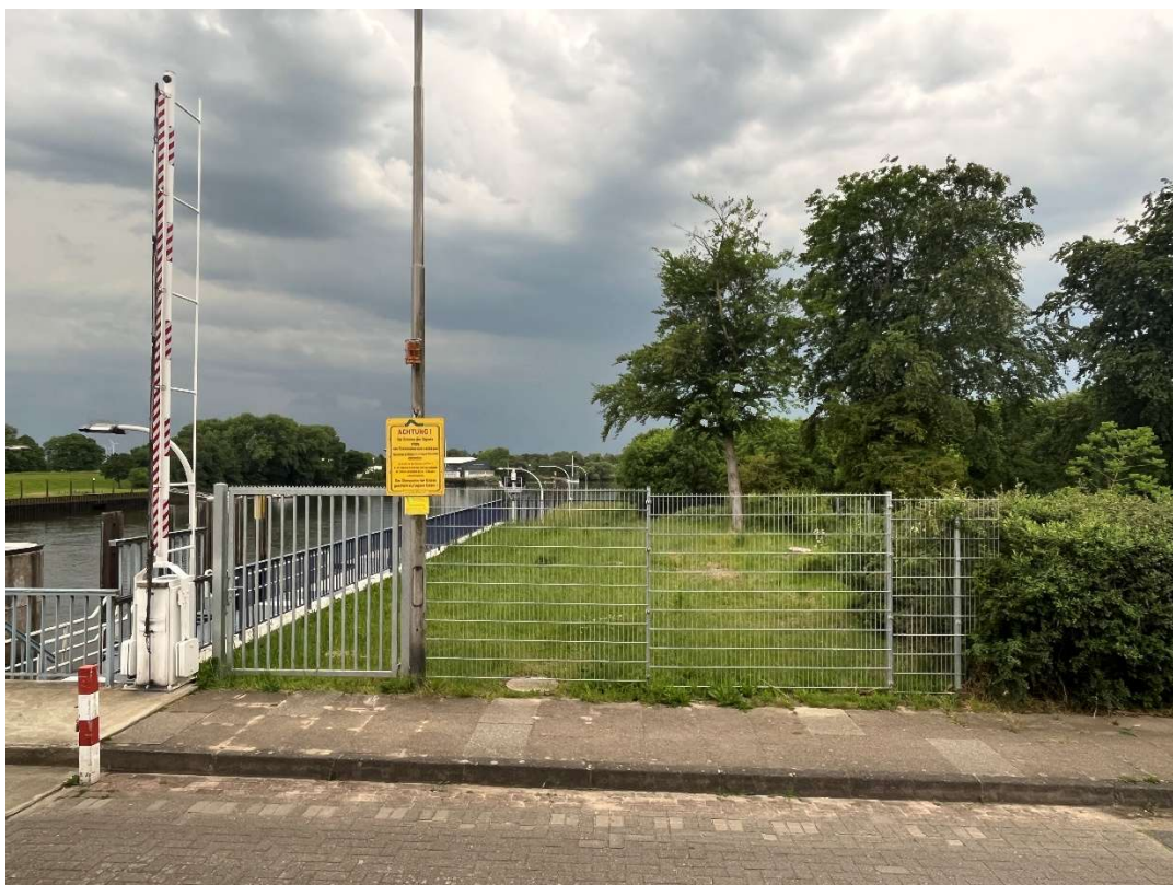
Foto 15: vorgesehener Kranstellplatz neben der Schleusenammer
