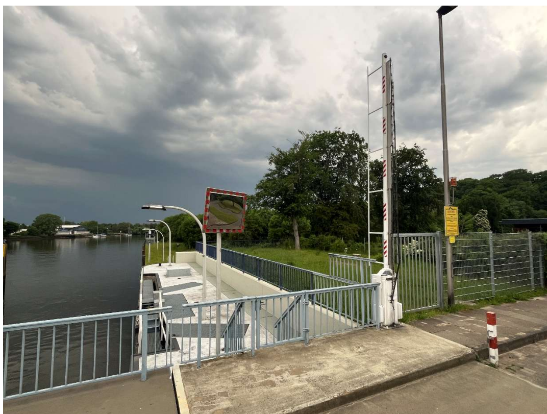
Foto 16: vorgesehener Kranstellplatz neben der Schleusenammer
