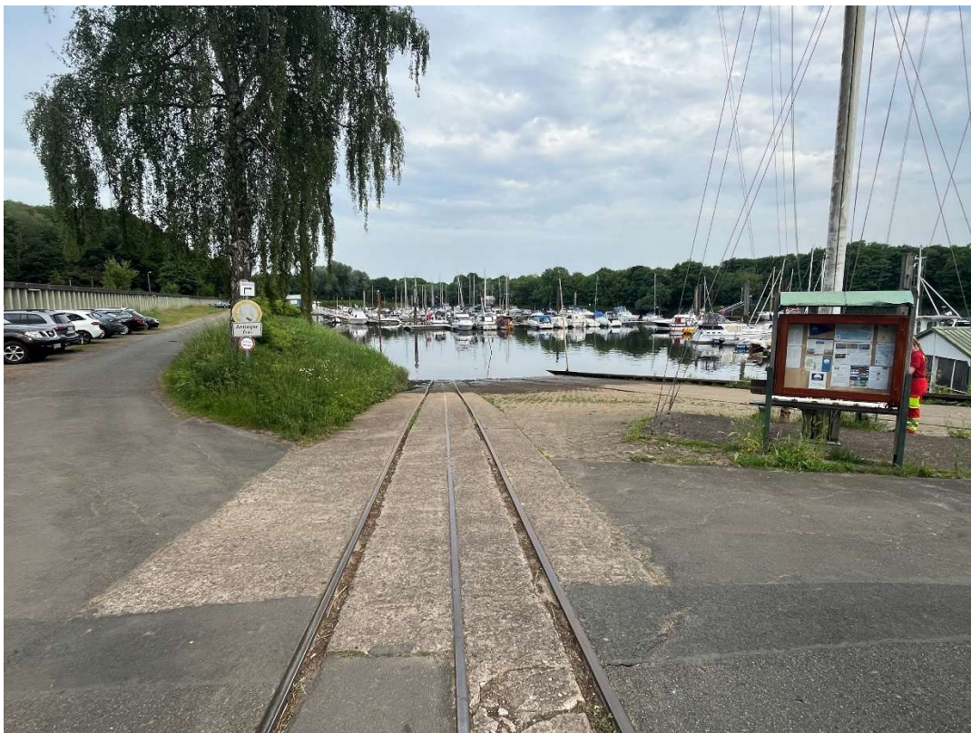
Bild 20: Slipanlage im Grohner Yachthafen; Breite ca. 12 m
