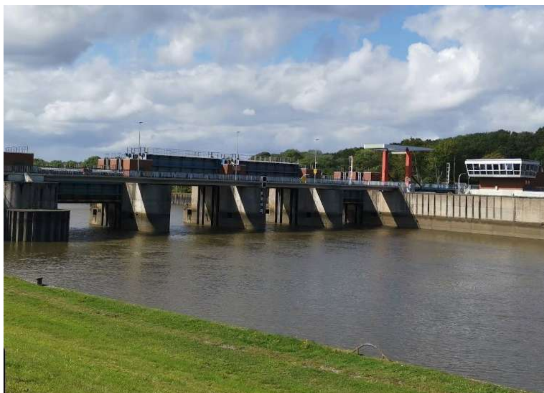
Foto 18: Blick auf das Sperrwerk von oberstrom
