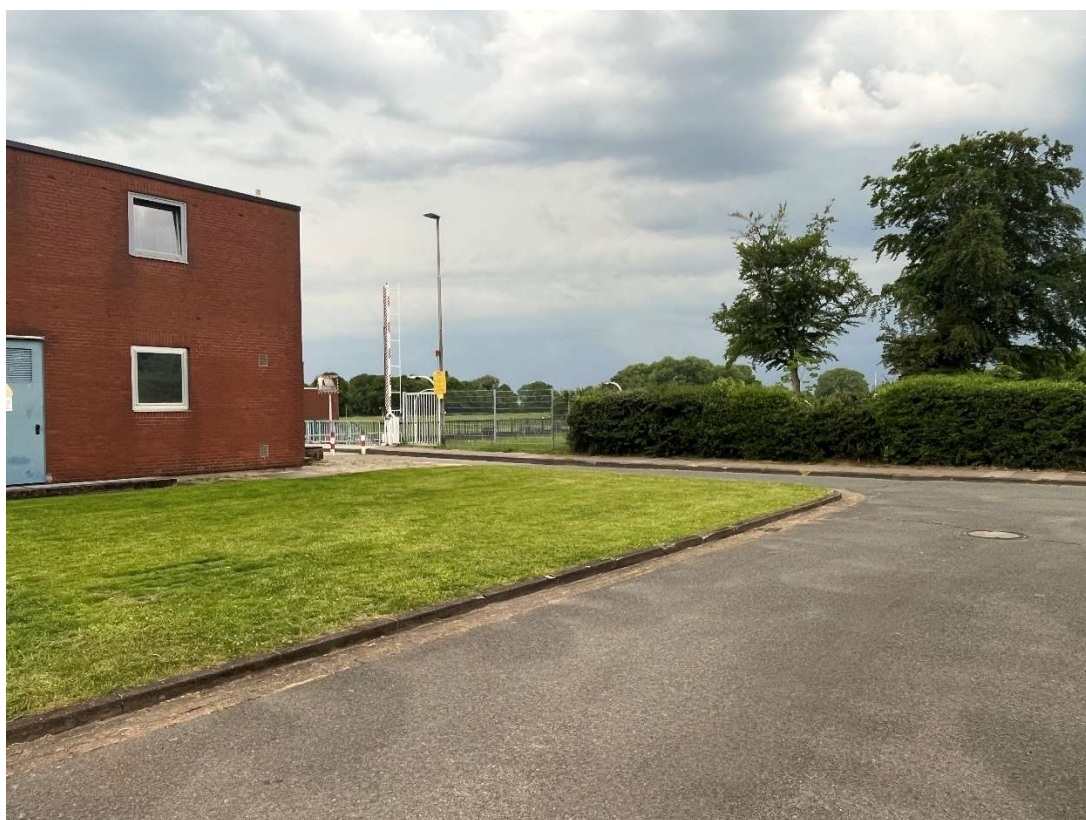
Foto 14: Betriebsfläche und Blick auf den vorgesehenen Kranstellplatz
